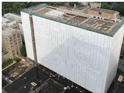
Image : Échafaudage de l'enveloppe de la tour Ferguson
